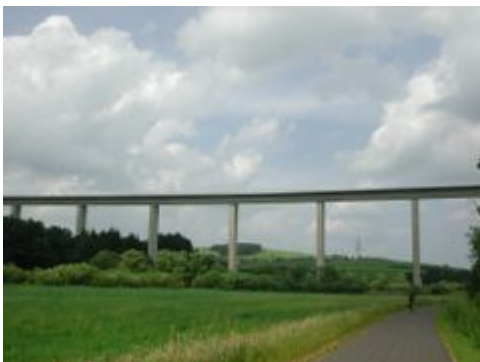
Autobahnbrücke bei Wutzerath
